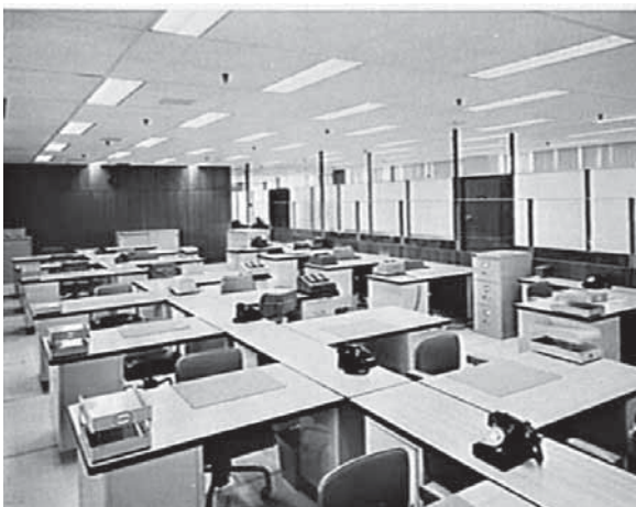
FIGURE 63 – TENANT FITOUT - ESSO
